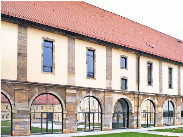
Abb. 22. Hoffront des Schlosses Zwickau-Planitz (1655–1721) mit Fassadenelementen aus Kohlesandstein (teilweise durch Fremdmaterial ersetzt).
